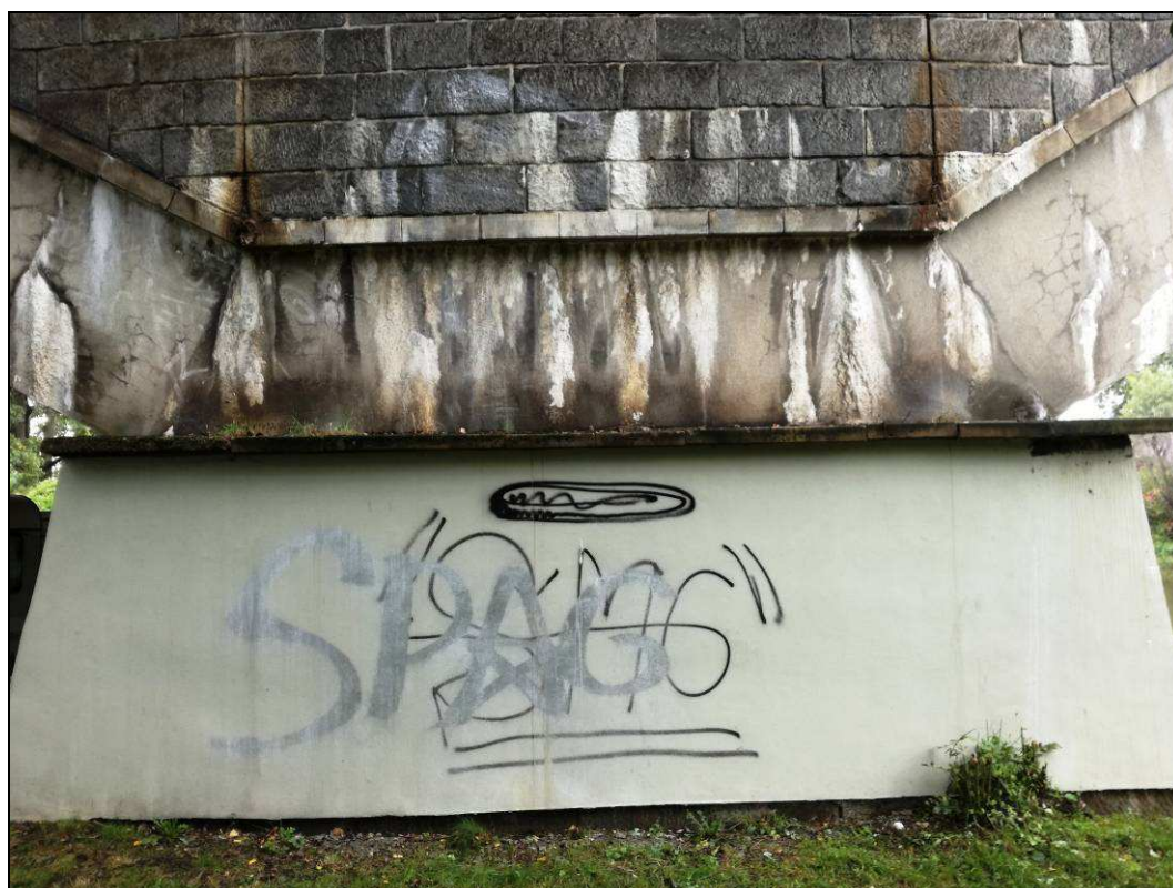
Obr. č. 6 - pohled zleva na středový pilíř - dlouhodobé průsaky vody mezi NK a SS
