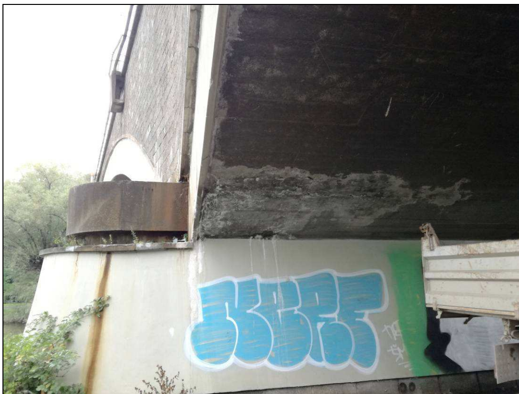
Obr. č. 6 - pohled středový pilíř - dlouhodobé průsaky vody mezi NK a SS
