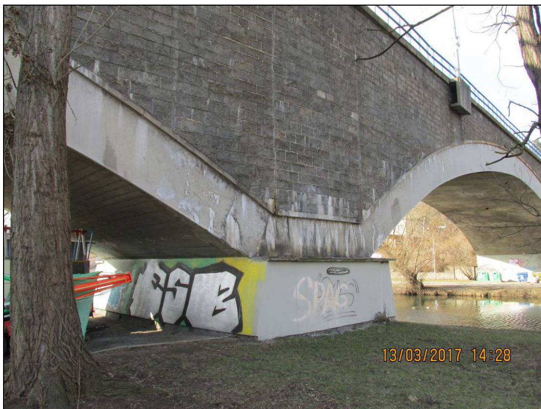
Obr. č. 5 - pohled zprava na středový pilíř - dlouhodobé průsaky vody mezi NK a SS
